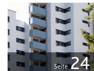
Energiebewusstes-Sanieren – Märkisches Viertel, Berlin
